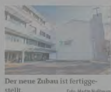
Der neue Zubau ist fertiggestellt. Foto: Martin Nußbaum
